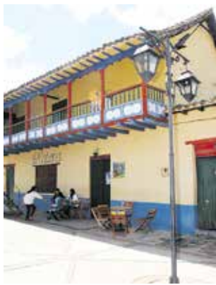
Pequeñas ventanas y balcones coloniales se observan en Tuta.
